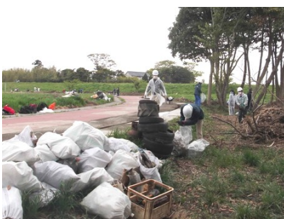
<がれきを土のう袋につめます>
