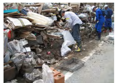
<ごみで埋まり見えない側溝>
