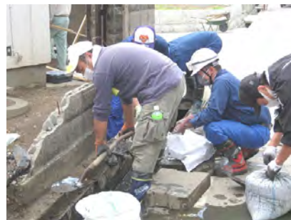
<側溝の泥をかきだします>
