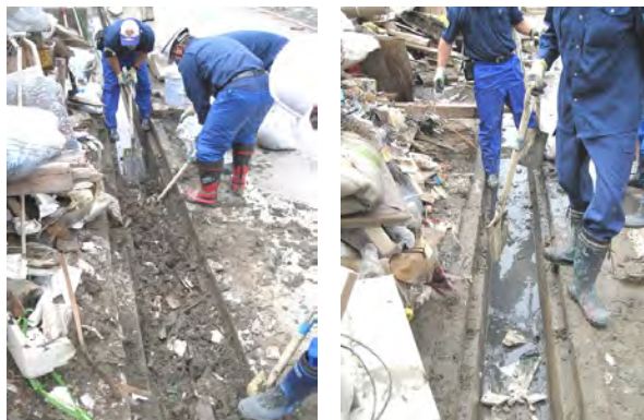
<左:泥でうまった側溝、右:作業後水が流れる>
