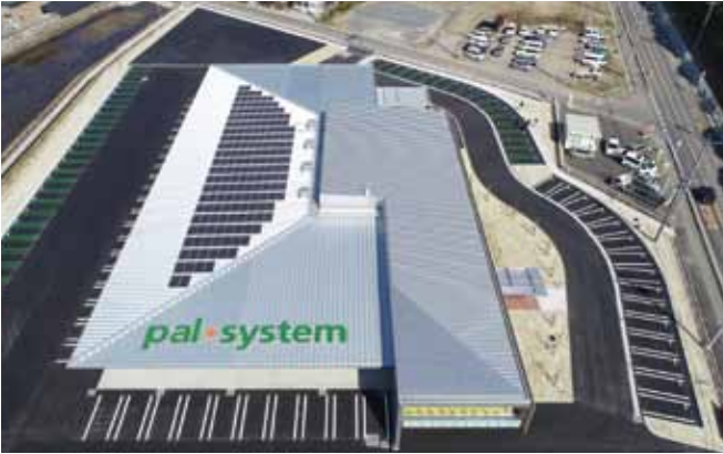
太陽光発電量の表示は1階エントランスのモニターに表示をおこない、データは2階事務室のPCに収集しています。
